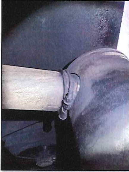
Local: Chassi Item # 36: silenciador do escape quebrado no tubo de saída. Status: corrigido .
