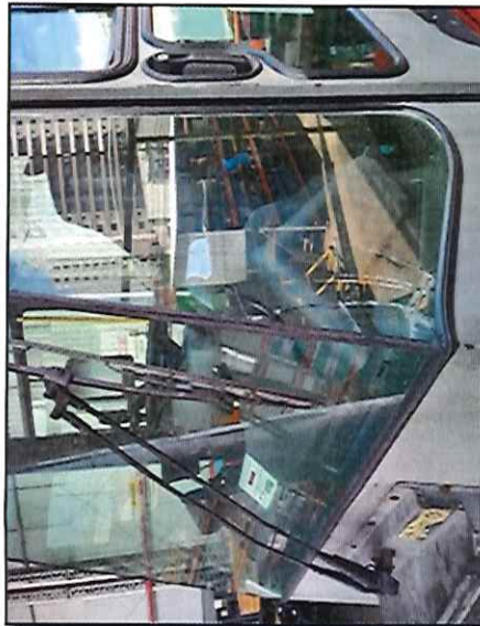
Local: Cabine Item # 04: vidros laterais da cabine trincados. Status: corrigido .
